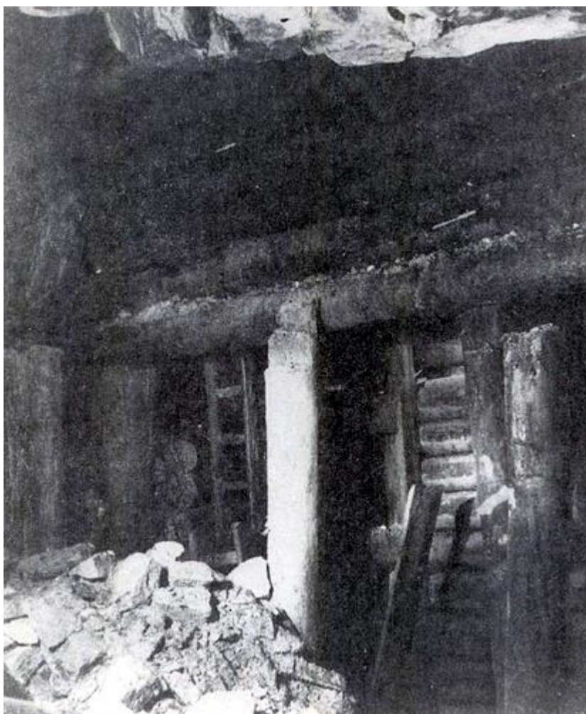
Náraží jámy Kaiser v úrovni horizontu Colloredo-Lauf Horizont 508 m n.m.
