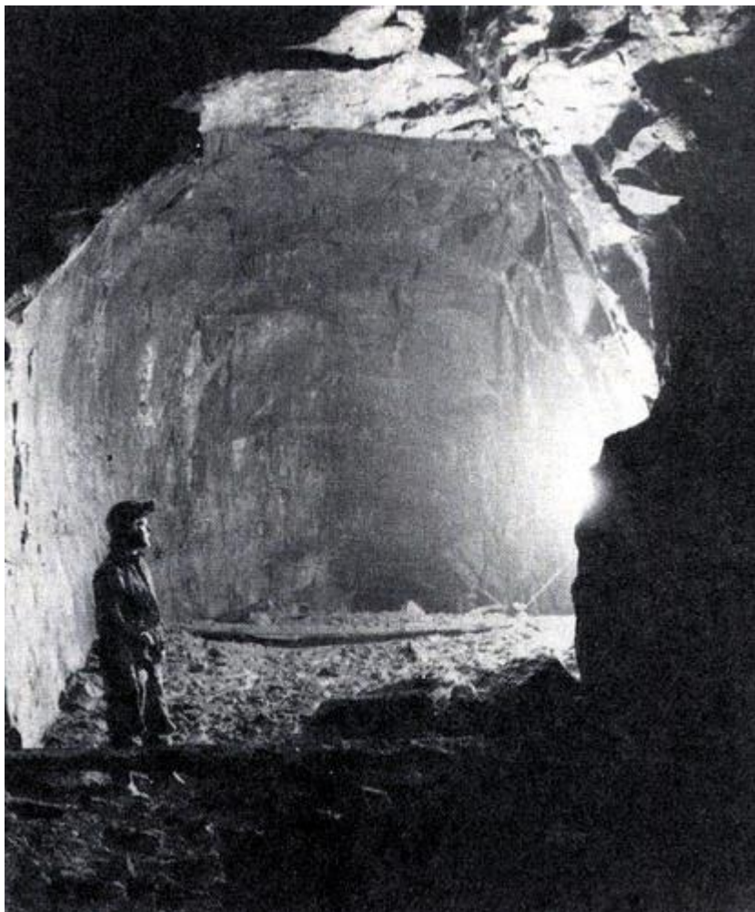
Pohled do komory vyrubané pomocí sázení ohně Horizont Sohlstrich 493 m n.m.
