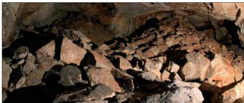
Obr. 5: Komora K4 – místo se sníženou stabilitou, výraznými opady stropu a závaly
