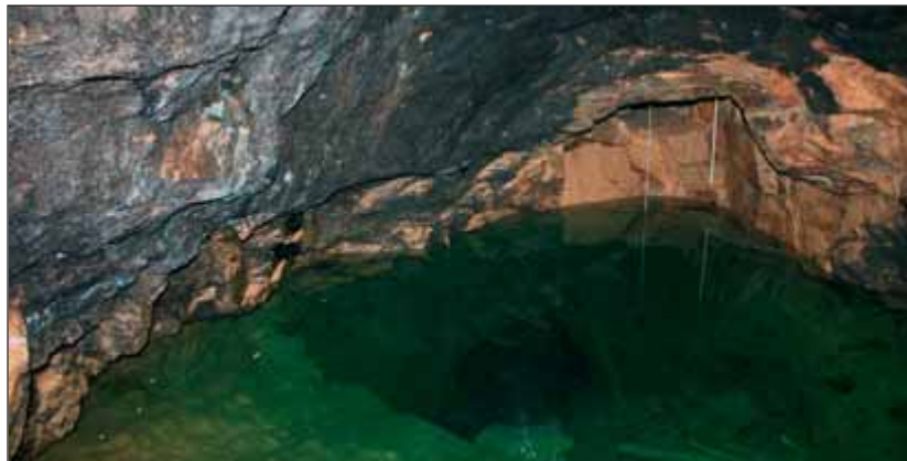
Obr. 3: Komora K3 (měřicí profil V3) během poklesu důlních vod
